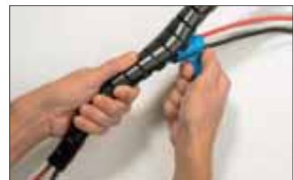
Plasser monteringsverktøyet i enden av Helawrap kabelbeskyttelse.
