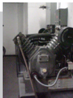
Luftkompressor – fullt synlig
