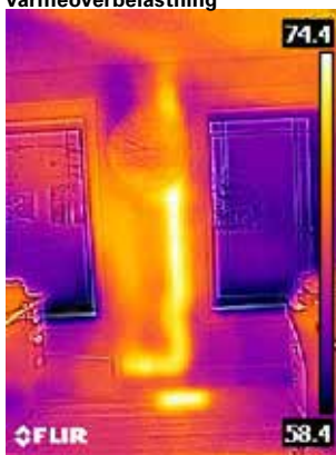
Varmeavløpsrør i vegg
