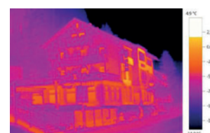
Image thermique avec testo ScaleAssist
