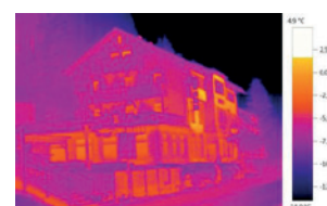
Imagen térmica con testo ScaleAssist
