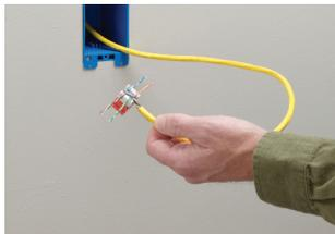
2. Déterminez le schéma de câblage. Préparez les quatre paires (huit fils).
