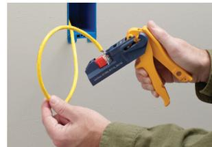
3. Insérez la prise dans l'outil JackRapid, les fentes IDC devant faire face aux lames du JackRapid.
