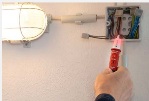
Testowanie przewodów pod kątem obecności napięcia AC w celu szybkiego wyszukiwania i usuwania awarii
